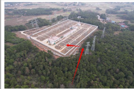
线路终点昆仑变电站
